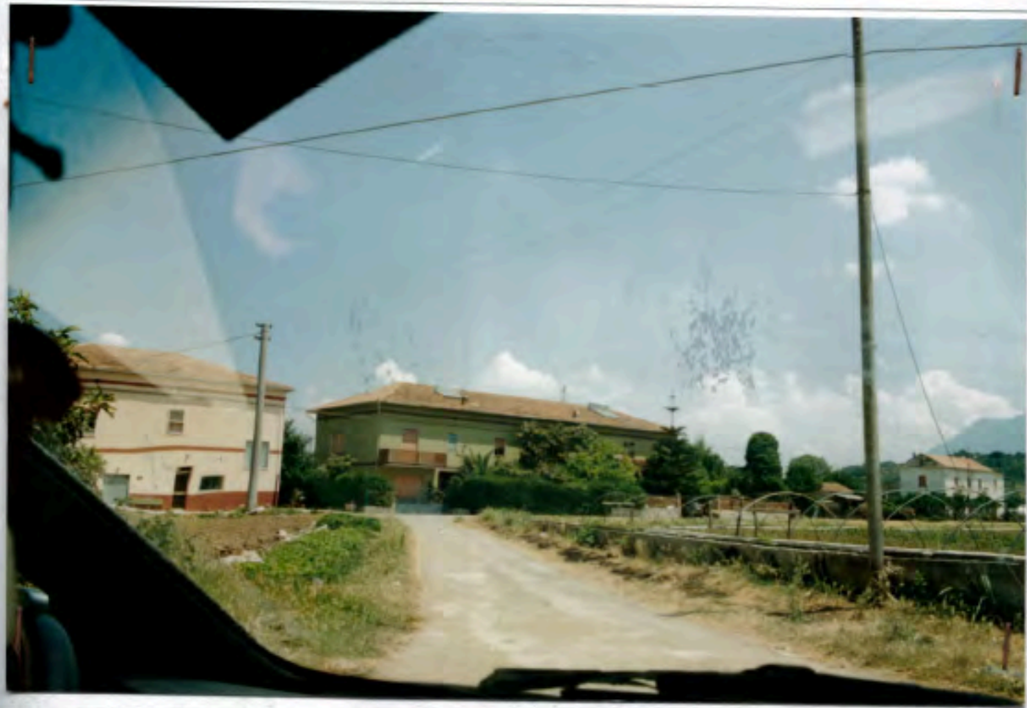
Foto n.1- Altavilla Silentina - Località Olivella Fabbricato sulla particella n.212 del foglio 5
